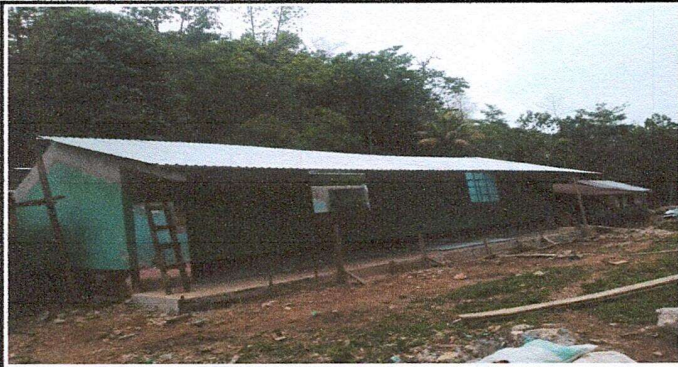
Foto 1: Colocación de láminas.
