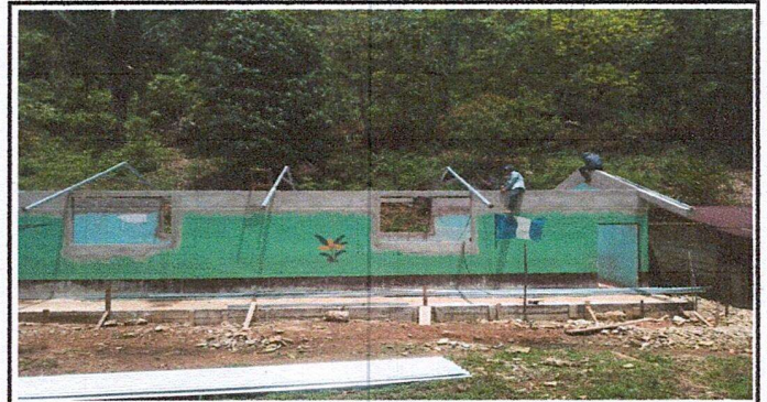
Foto 4: Collocación de costaneras.
